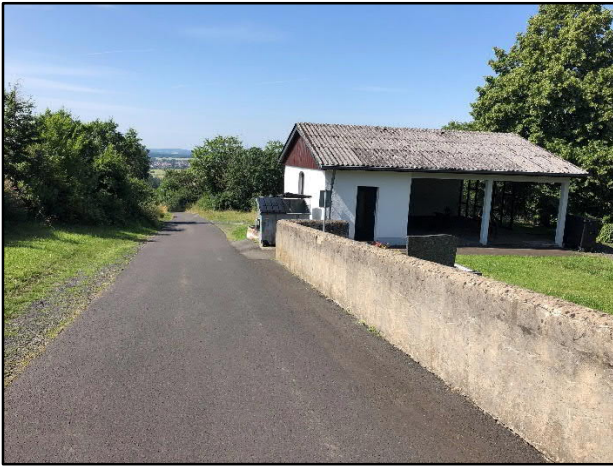
Abbildung 8: Blick von Norden (Feldweg, Einsegnungshalle)
