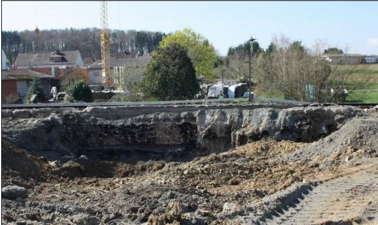
Foto 4: Ehem. Asphaltmischanlage, Wand Gleiskörper, Sanierungsbereich S-III, Lage ca. KRB-9, -11 und -50
