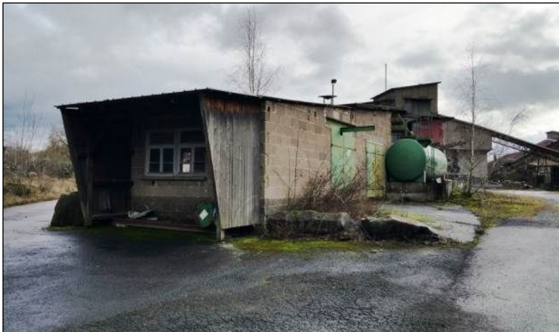
Foto 2: Ansicht der ehemaligen Ölhalle und die dahinter befindliche Tankstelle mit Waschplatz
