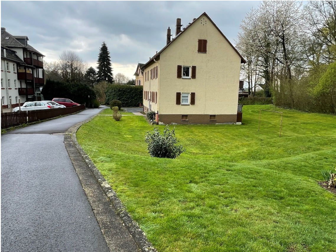
Abbildung 8: Ausgeführter Hochkeller im Zusammenhang mit Geländeabtrag
