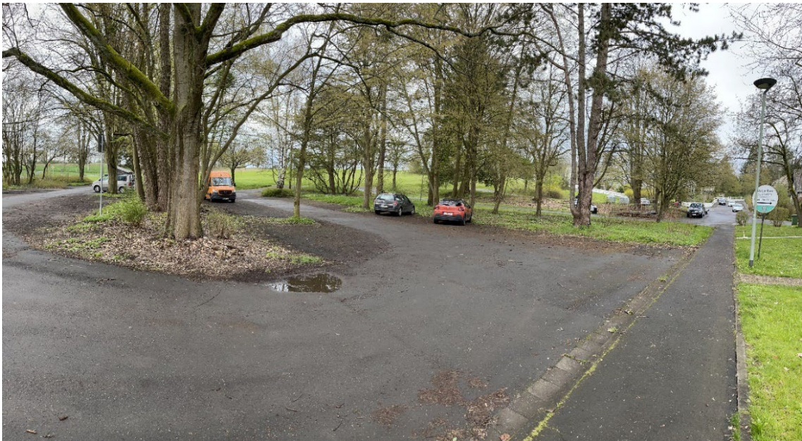
Abbildung 2: Blick vom östlichen Erschließungsrand (Geländetiefpunkt) aus nach Westen (Panoramaaufnahme)
