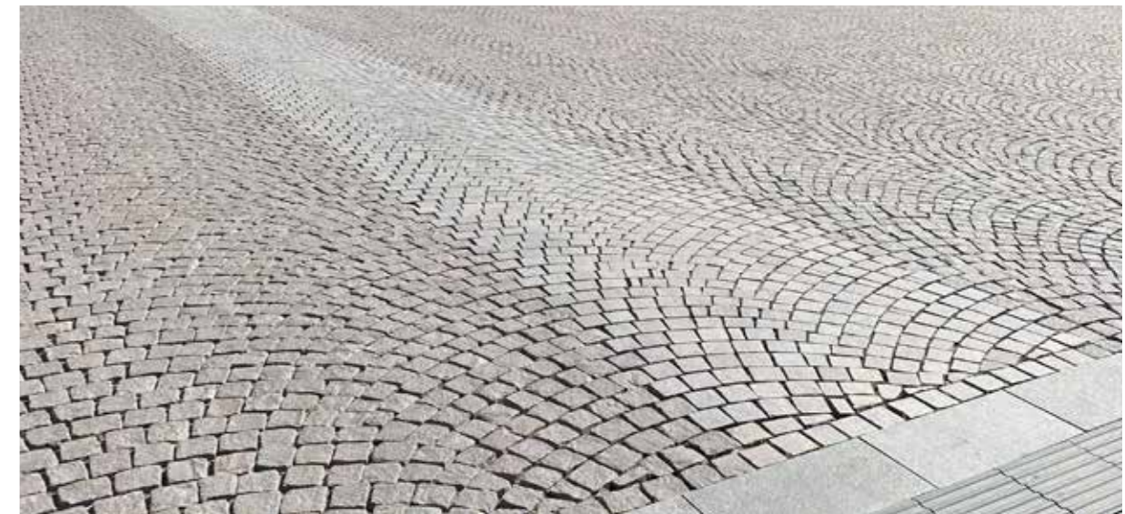
Gesägtes Kopfsteinpflaster verbessert die Barrierefreiheit und fügt sich optisch gut in die Platzgestaltung ein. Bsp.: Friedensplatz Darmstadt
