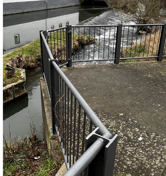
Bestandsgeländer mit neuem Handlauf
