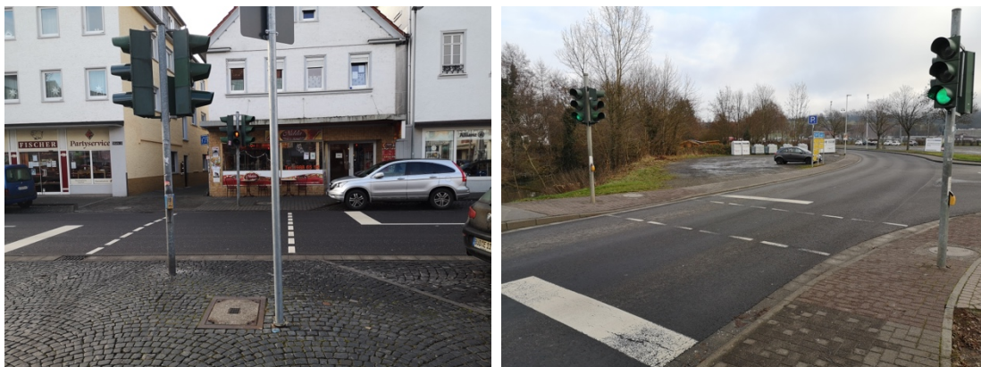
Abbildung 9: Fußgängerschutzanlage am Marktplatz und in der Krötenburgstraße
