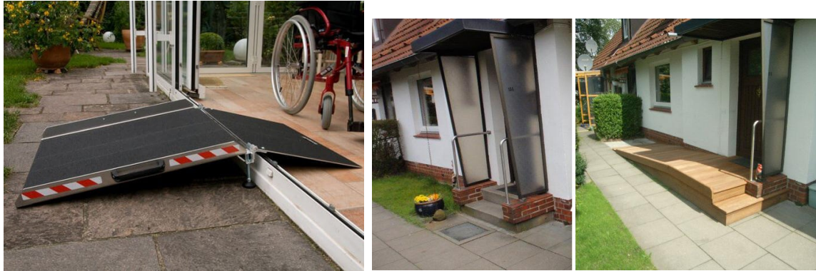
Abbildung 24: Türschwellenrampe (links) 18 und barrierefreier Umbau der Eingangssituation (rechts) 19
