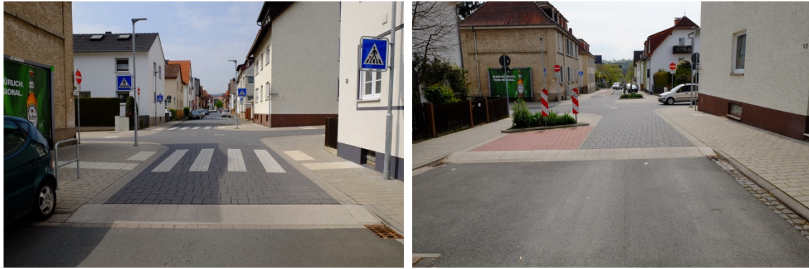
Abbildung 36: Aufpflasterung mit Sinussteinen und barrierefreier Querungsmöglichkeiten in Hofheim (eigene Aufnahme)
