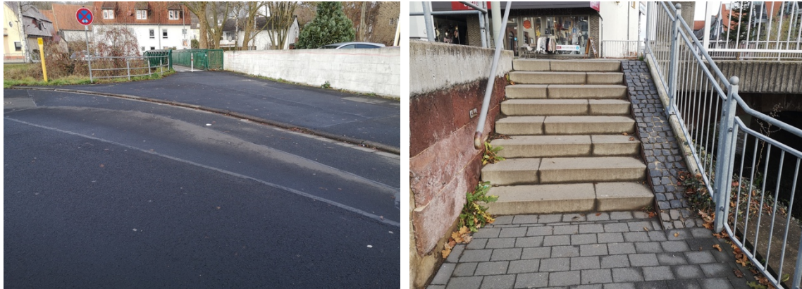
Abbildung 20: vorhandenes Bord erschwert Erreichen des Fußwegs (links), vorhandene Treppe kurz vor der Neuen Straße (rechts)
