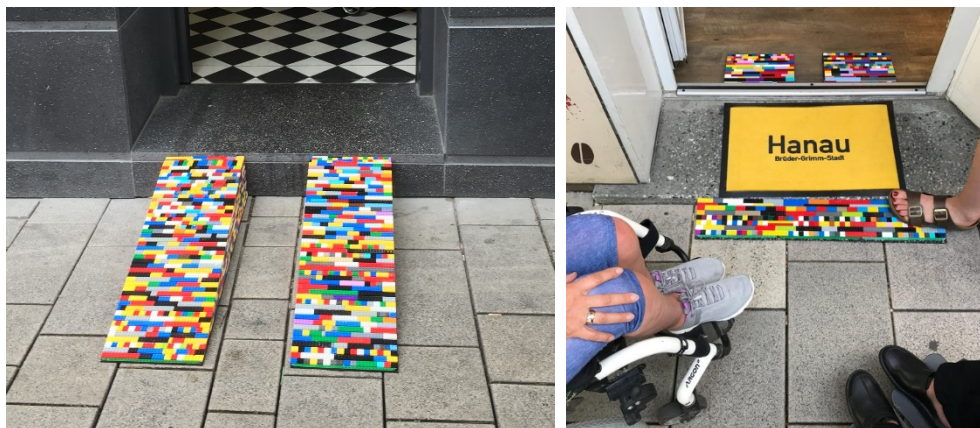
Abbildung 23: Beispielhafte Ausführung der Lego-Rampen an Eingängen in Hanau 17
