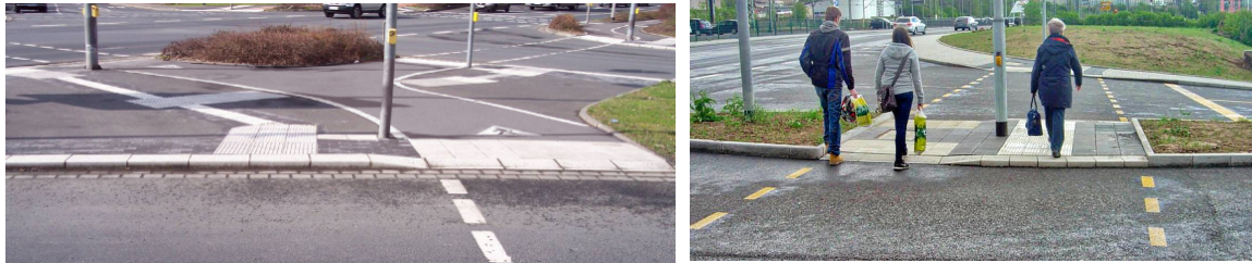
Abbildung 30: getrennte Führung seh- und mobilitätseingeschränkter Personen am Beispiel Retzbach (links) 35 und Fulda (rechts) 36
