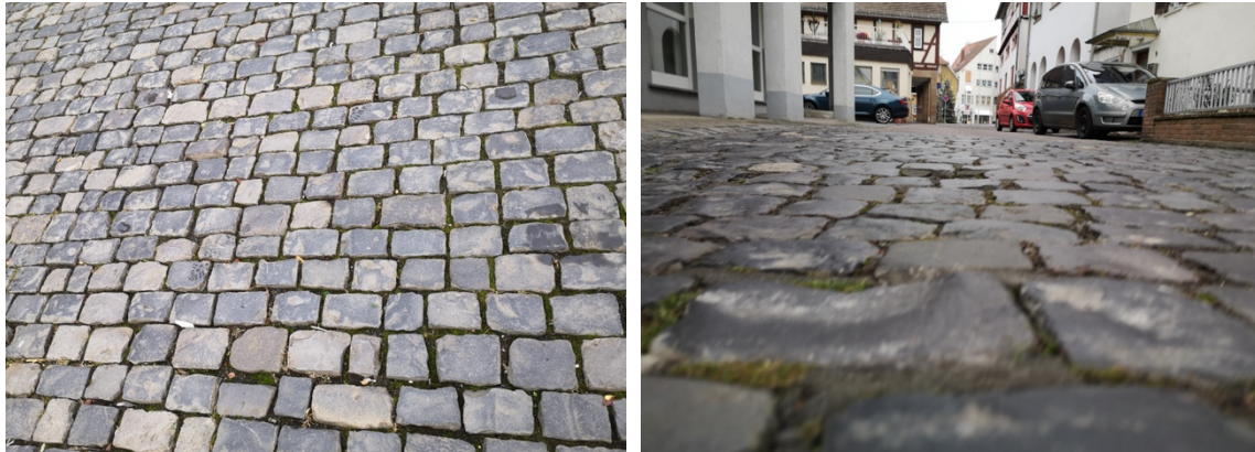
Abbildung 12: große Fugen zwischen dem abgerundeten Altstadtpflaster sowie deutliche Höhenunterschiede im Verlauf
