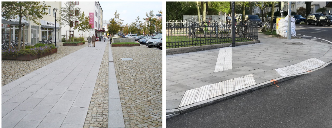
Abbildung 34: Kontrastreiche Fußgängerwege mit großen, fugenarmen Platten sowie deutlichem Kontrast gegenüber den umliegenden Verkehrswegen 41,42
