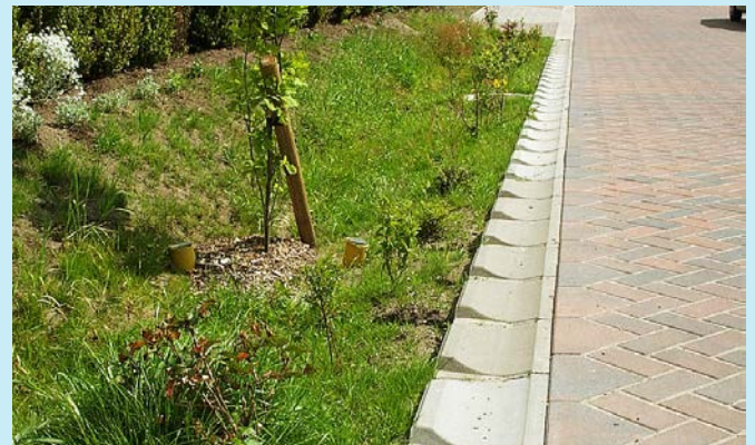
Abbildung 11: Mulden-Rigolen-System
