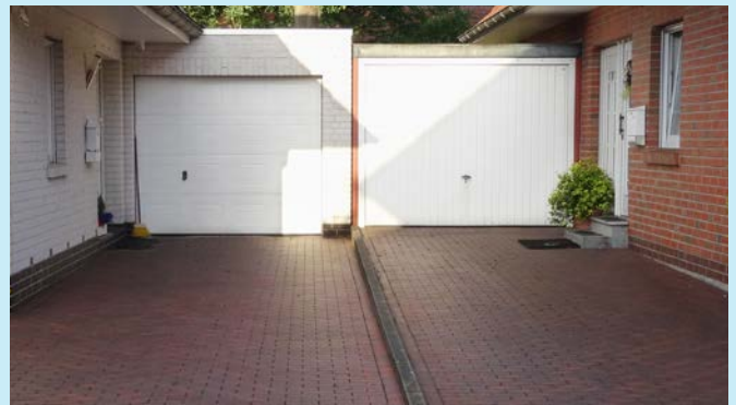
Abbildung 21: Die ansteigende Einfahrt rechts schützt Haus und Garage vor Oberflächenwasser
