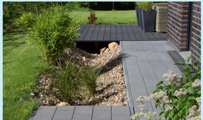
Abbildung 8: Versickerungsgraben
