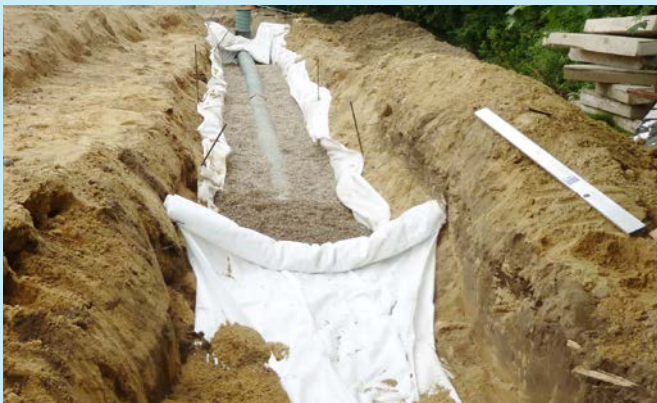
Abbildung 12: Rohrrigole
